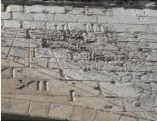
Fig. 6. État de dégradation avancé du centre.
