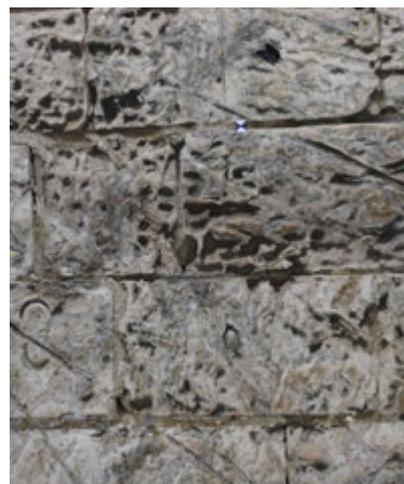
Fig. 10. Exemple de zone rongée par les intempéries.
