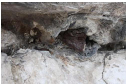
Fig. 24. Reste du style scellé au plomb.
