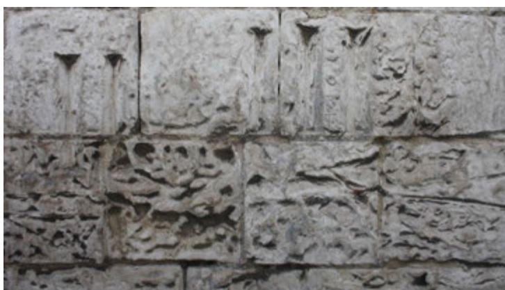
Fig. 11. Partie supérieure chiffrée érodée.
